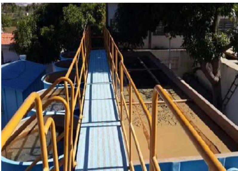
Figura 60 – Filtros e decantador da ETA Convencional 2.
