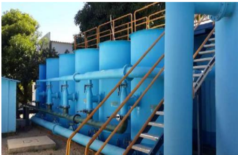
Figura 59 – Unidade de tratamento do tipo convencional/compacta.
