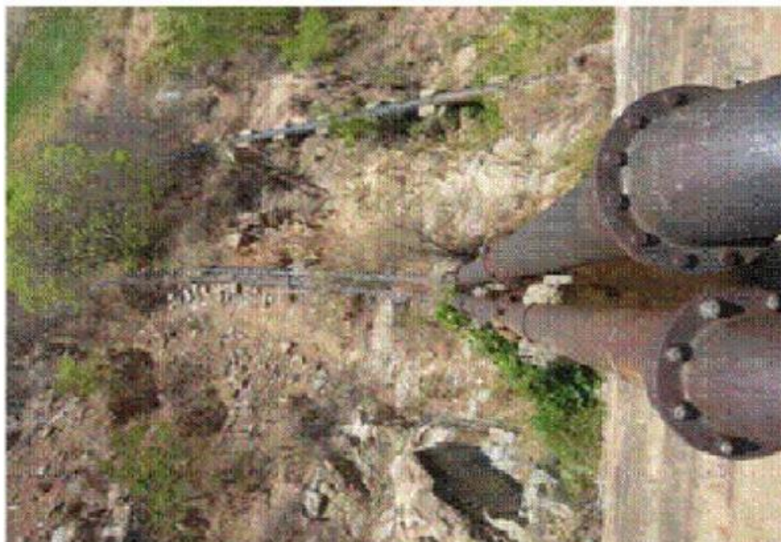
Figura 46 – Tomadas de água da captação de água na Barragem Cachoeirinha II.
