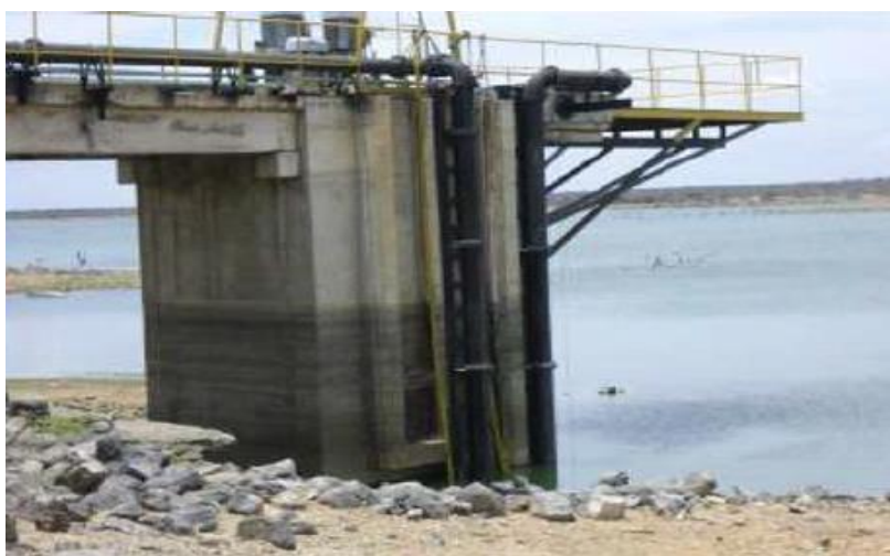
Figura 48 – Tomadas de água da captação de água da Adutora do Pajeú.
